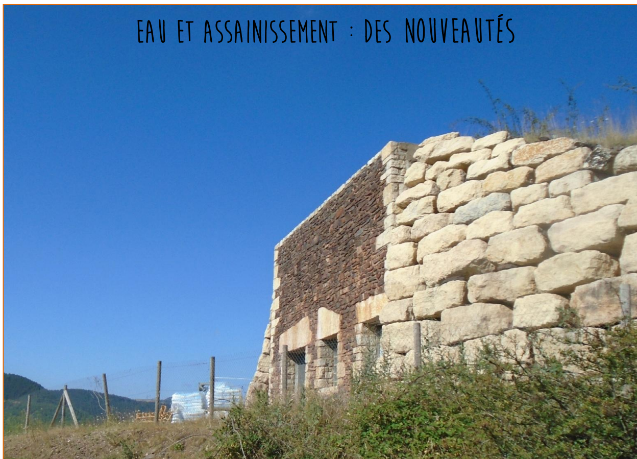
Le château d'eau sur le chemin de Bourlande
